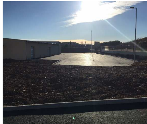
13. Accès de service aux locaux techniques
