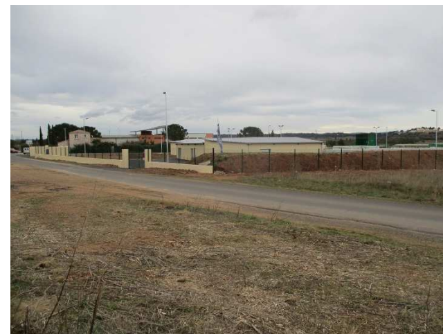
Photos de la déchèterie d'Aspiran : merlon de terre coté autoroute, sortie et entrée de la déchèterie (mur bahut côté route, grillage vert sur le pourtour) et murs matérialisant l'entrée et la sortie), vue côté pont sur l'autoroute.
