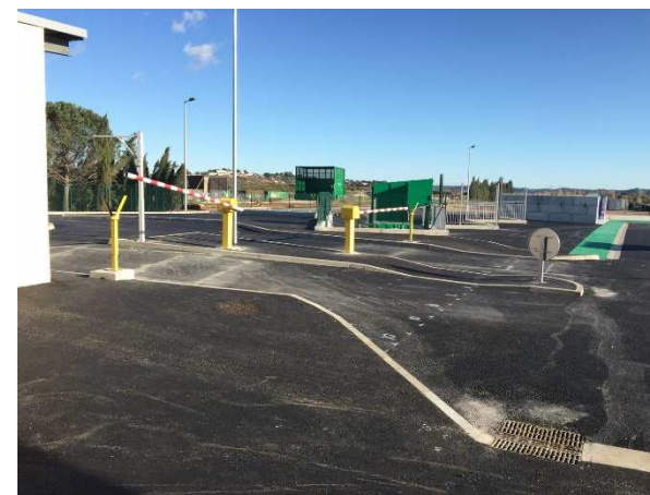
Photos de la déchèterie d'Aspiran : entrée de la déchèterie, voie de service, emplacement des barrières levantes entrée et sortie et des futurs portiques de gabarit.
